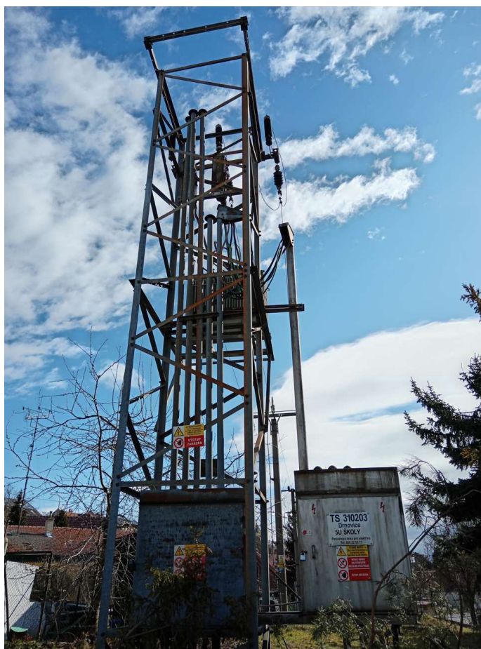
Obr.2 Stávající trafostanice pro ZŠ Drnovice
